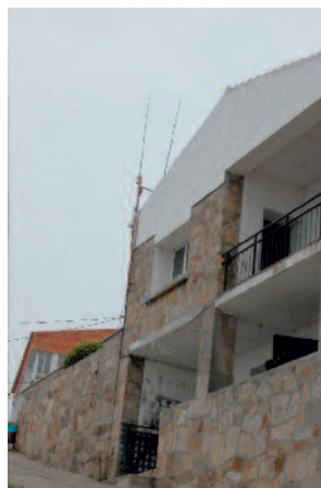
Edificio de la antigua sociedad mercantil
